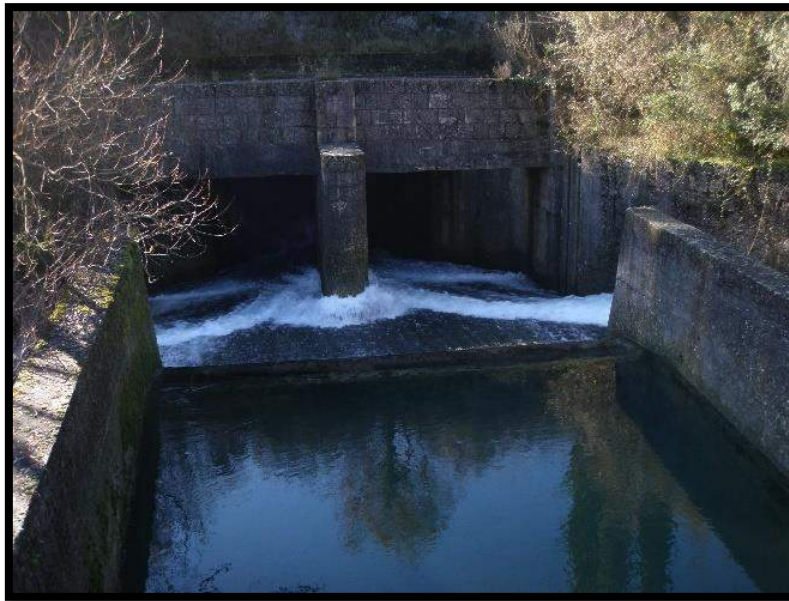
Slika 6 Ulaz u tunel
