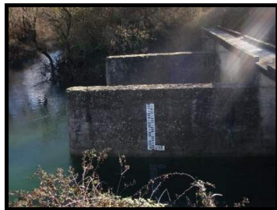
Slika 5 Ulazna građevina (početak)
