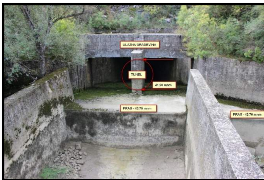
Slika 11 Ulazna građevina
