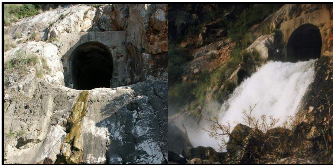
Slika 2 Izlazni portal tunela
