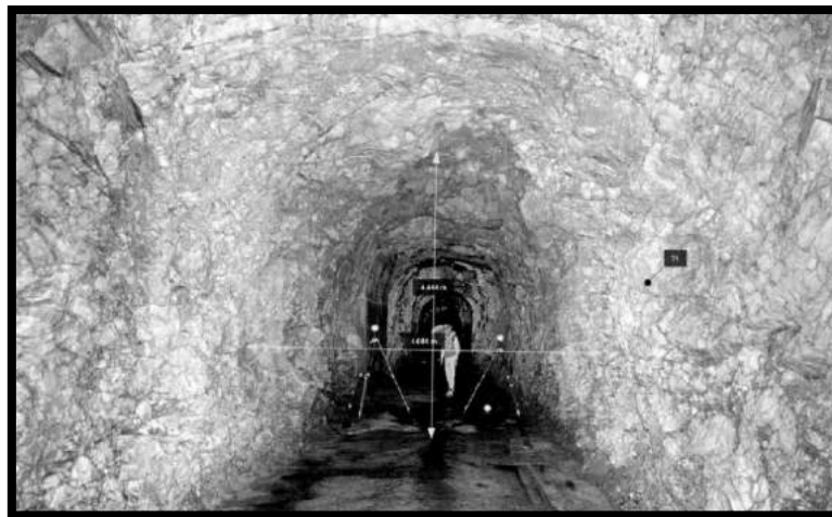
Slika 4 Okršena vapnenačka stijena na kraju tunela – lasersko skeniranje tunela
