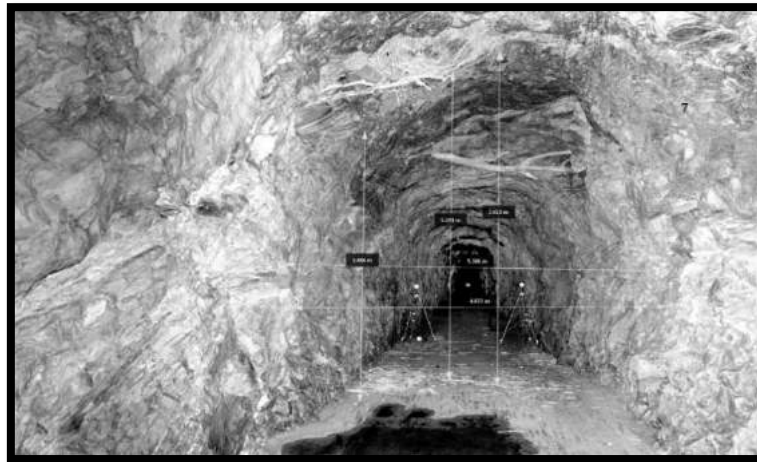
Slika 3 Okršena dolomitna stijena na početku tunela – lasersko skeniranje tunela
